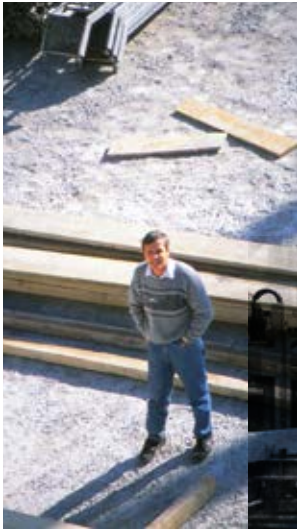
1989. Hermann Blumer beim Bau der Werkhalle der Lignatur AG
