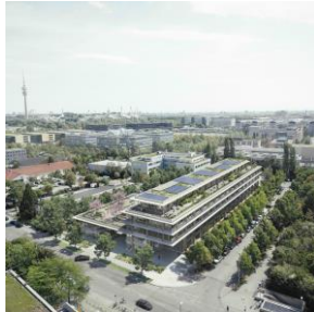
Timber Works, München BMF: 9.700m 2 Fertigstellung: Q3/26
