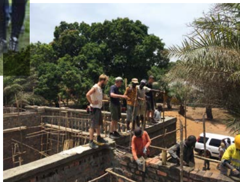
Sri Lanka: eine von 14 Studentenbaustellen im Rahmen der Professur
