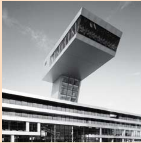
Neue Mitte Lehen Salzburg, Austria
